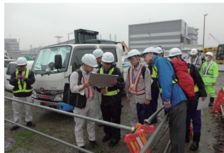
羽田アクセス線施工に伴う施工検討
